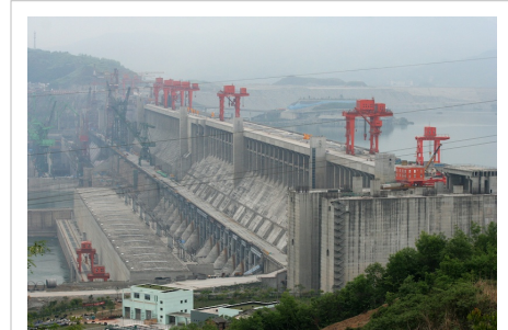
Le barrage des Trois-Gorges, dans la province du Hubei en Chine, est le plus grand barrage ainsi que le plus grand générateur d'électricité au monde [2] .
