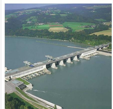
Centrale hydroélectrique de Ybbs-Persenbeug en Autriche
